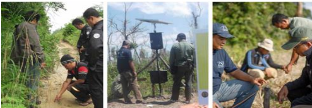
GAMBAR 7 Pemasangan pagar listrik efek kejut bertenaga surya yang ramah terhadap kelangsungan hidup harimau dan hewan pemangsanya serta manusia telah dipasang pada dua lokasi yang paling rawan terjadinya konflik manusia dengan harimau Sumatera di kawasan perbatasan Taman Nasional Berbak
